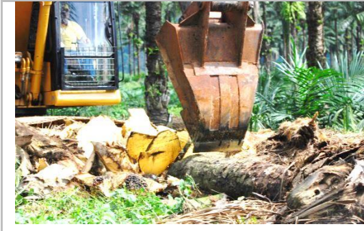
รูปที่ 6.21 การทำลายต้นปาล์มน้ำมันเก่า โดยใช้รถแบคโฮล้มแล้วสับต้น
